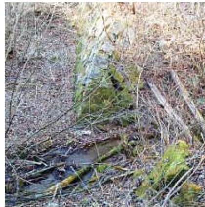
橋台の残骸で右岸に渡ると知れる
