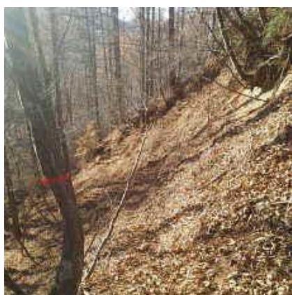
捲きの部分は崩れて踏跡程度に
