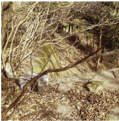
次の堰堤や護岸など人工物が続く
