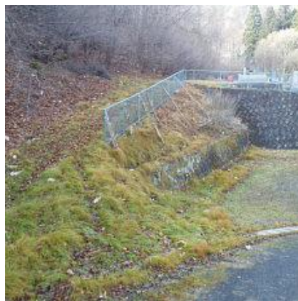
御岳霊園の取付道で車道に合流
