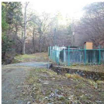
御岳町の水道施設から漸く山道になる
