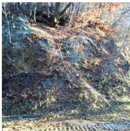
御岳林道横断時は崖状の法面を突破
