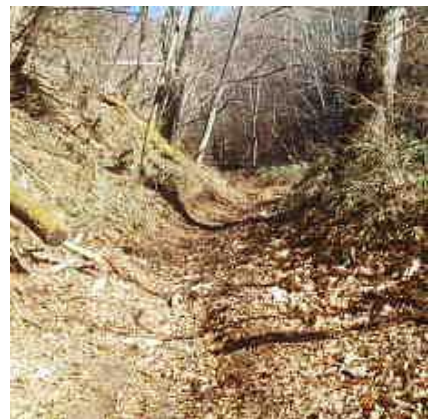
廃車道化した車道がなお続く
