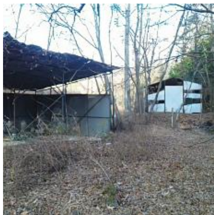
トタンの作業場とプレハブ脇を通過
