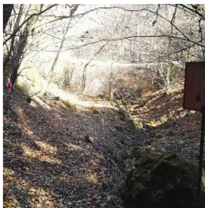
前方を横切る猫坂林道の擁壁
