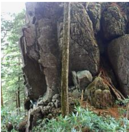
この岩頭先の崖で道が消えたのは、棧橋崩落のためか
