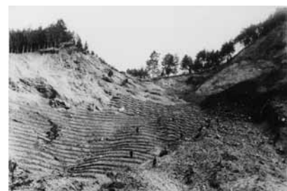
吾野崩壊現場復旧工事 大正2年撮影 埼玉県庁提供
