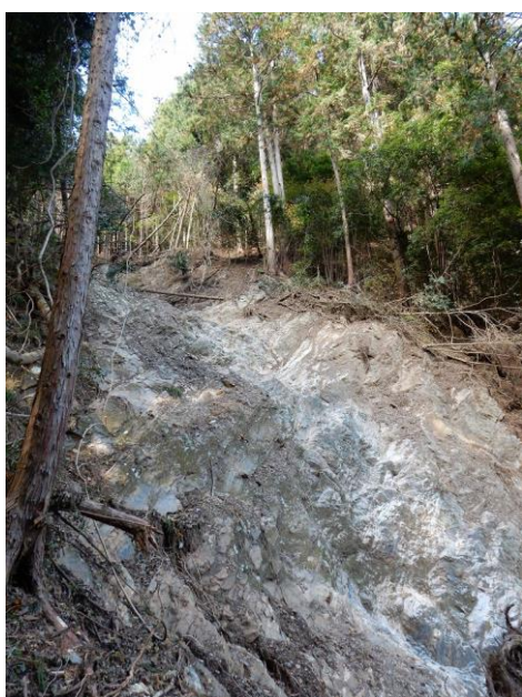
写真8 第1の崩落現場 (岩盤まで土がえぐられている)
